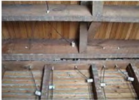
KNOB & TUBE WIRING
